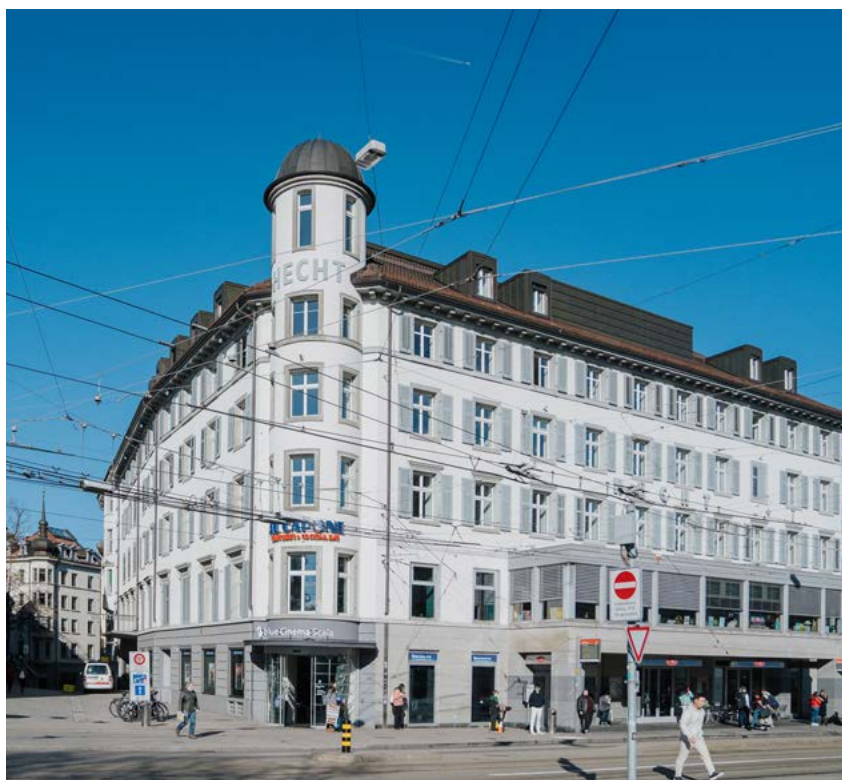
Gasheizung Geschäftshaus Bohl 1
