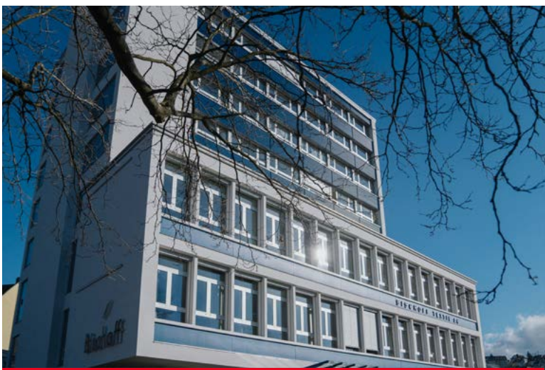
Fernwärme Bischoff Textil AG, St. Gallen
